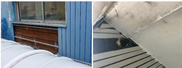
Figura 4.3 - Particolare isolamento parete e solaio su esterno
